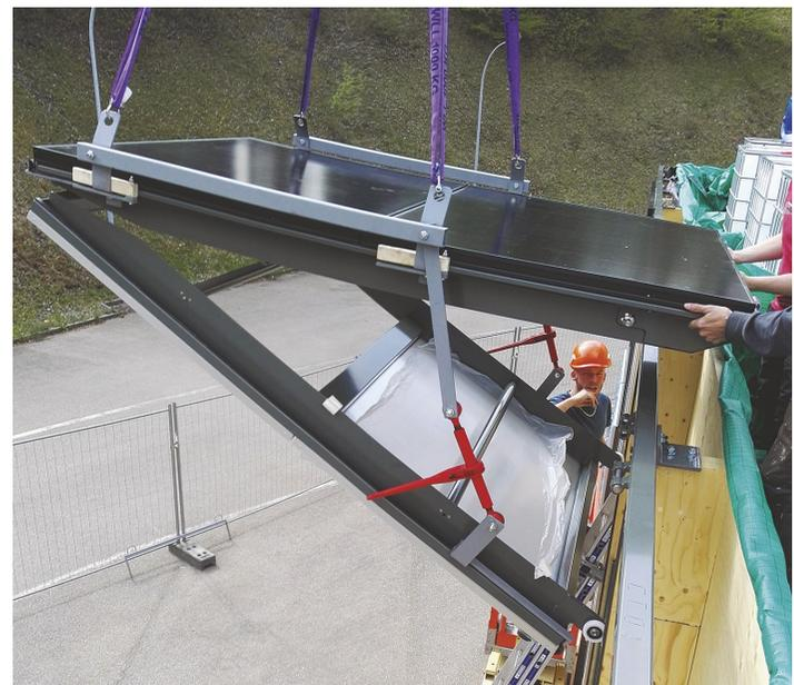
**Una fase dell'installazione dei serramenti basculanti che, in posizione di apertura, inclinano i moduli monocristallini a 17° permettendo di ottimizzare l'esposizione durante la stagione calda** (Credito: Portes Brodard)
