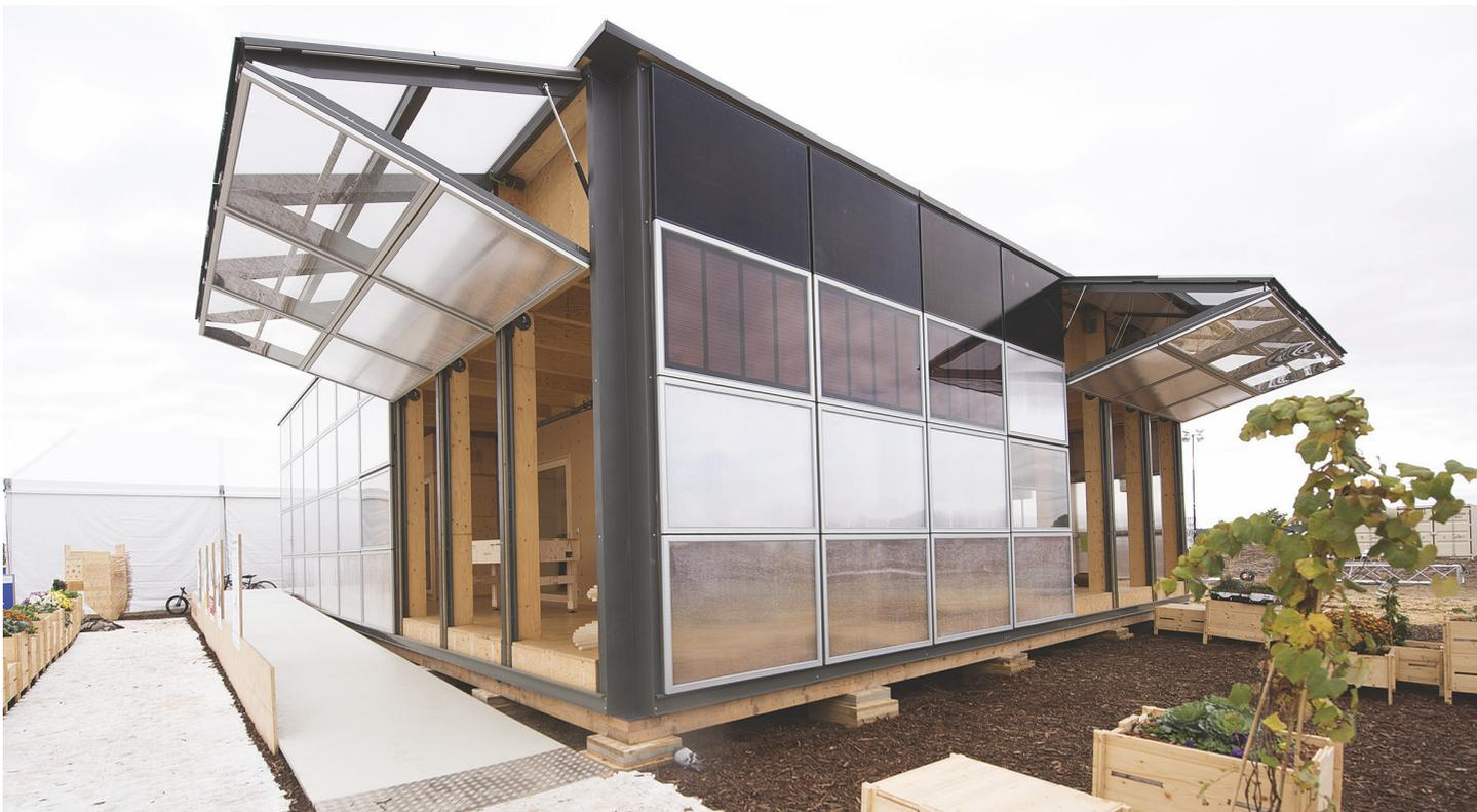
Per ottimizzare produzione e autoconsumo dell'energia i moduli fotovoltaici sono esposti sulle facciate est, sud e ovest (a destra); sotto i pannelli monocristallini si notano anche i 12 moduli DSSC di colore rosso (Credito: Dennis Schroeder; U.S. Department of Energy Solar Decathlon)
